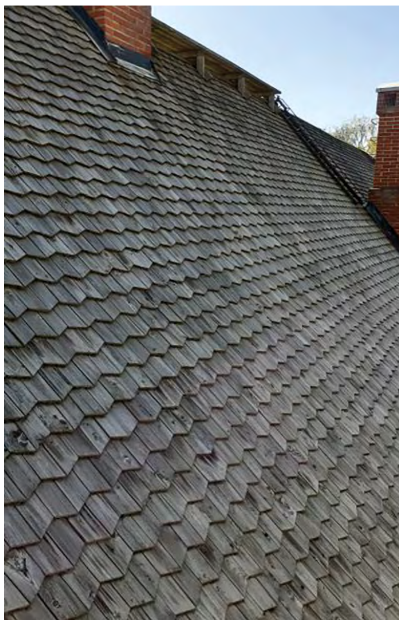
Bild 3. Ett tak som behandlats med substitut ser ofta ut så här: ytbehandlingen slits snabbt bort och stöter ifrån sig furutjära. Största delen av spånen är dock fortfarande hela. Bild Antti Pihkala.
