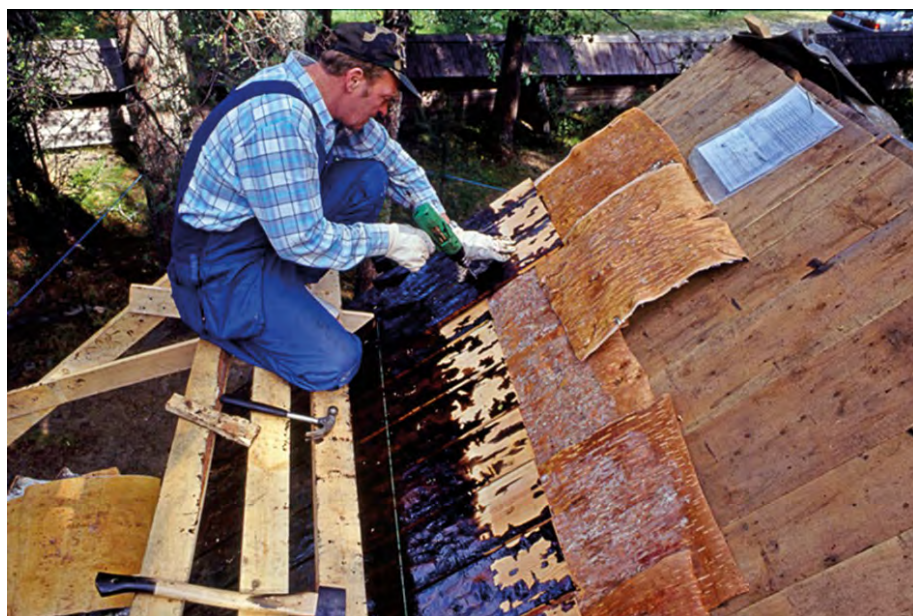
Bild 14. Näver i ett lager som underlagstak under spånbeläggningen. Bild Lauri Yli-Tepsa.
