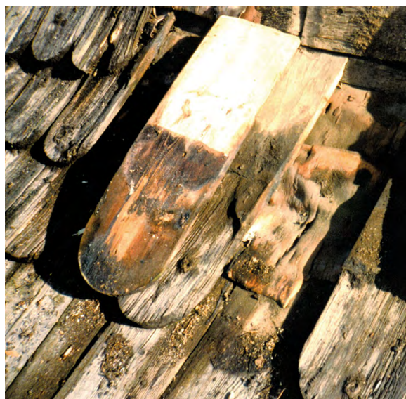
Bild 15. På taket till klockstapeln i Himango har spån- och näverskift lagts turvis. Ett spån har lösgjorts från sin plats. Under det syns ett skift av näversjok. Bild från 1995 Julius Kotivuori.
